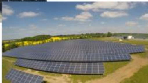
Duża instalacja ( moc > 500 kWp)
