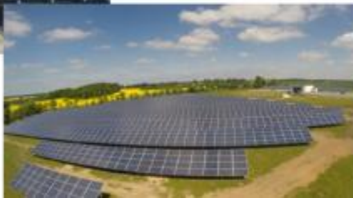
Duża instalacja ( moc > 500 kWp)
