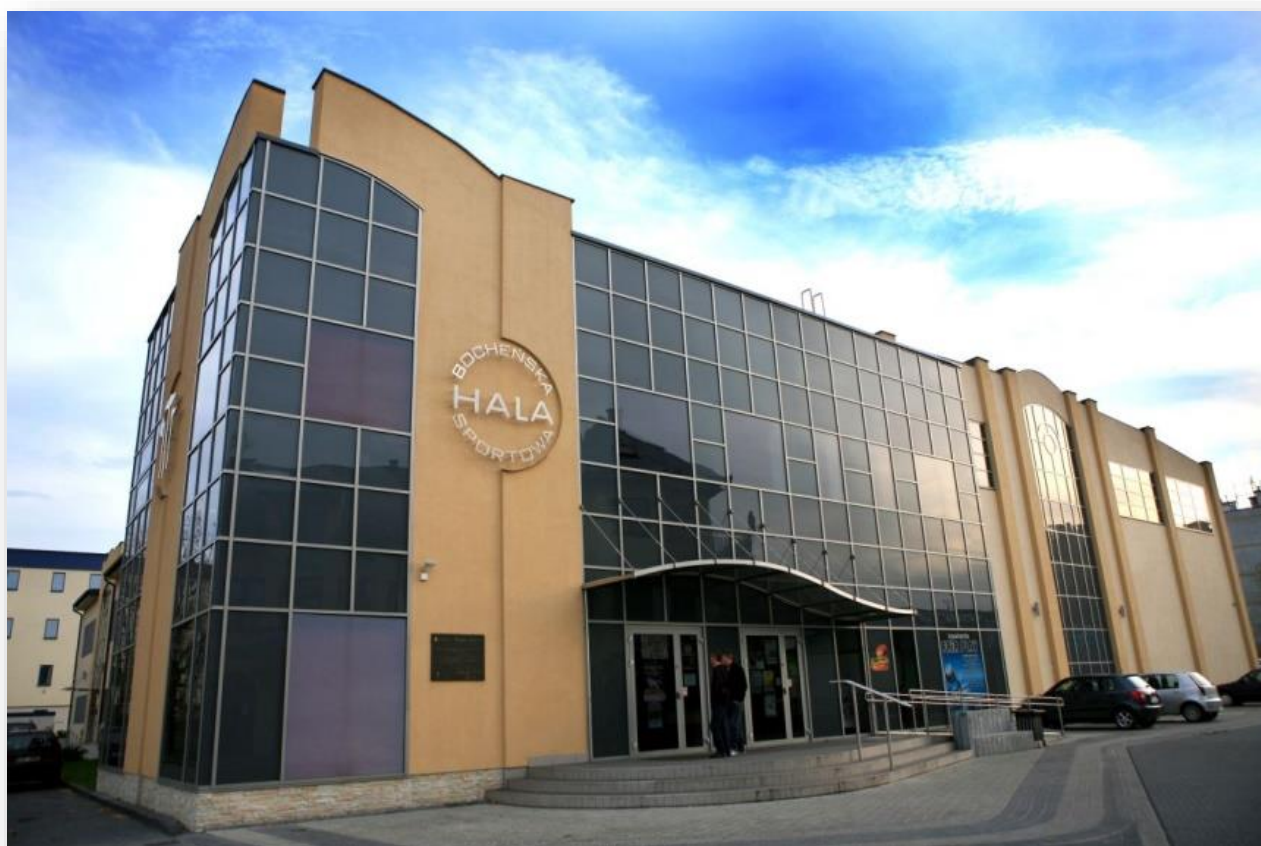
Hala widowiskowo – sportowa w Bochni
