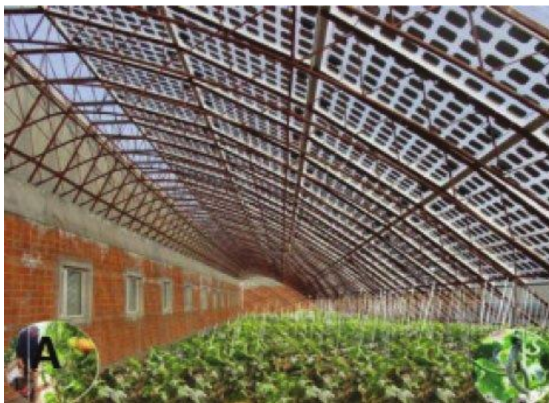
Rysunek 6.10 Uprawa w szklarni z przeziernymi modułami PV (źródło: Bundschuh et al., 2017)
