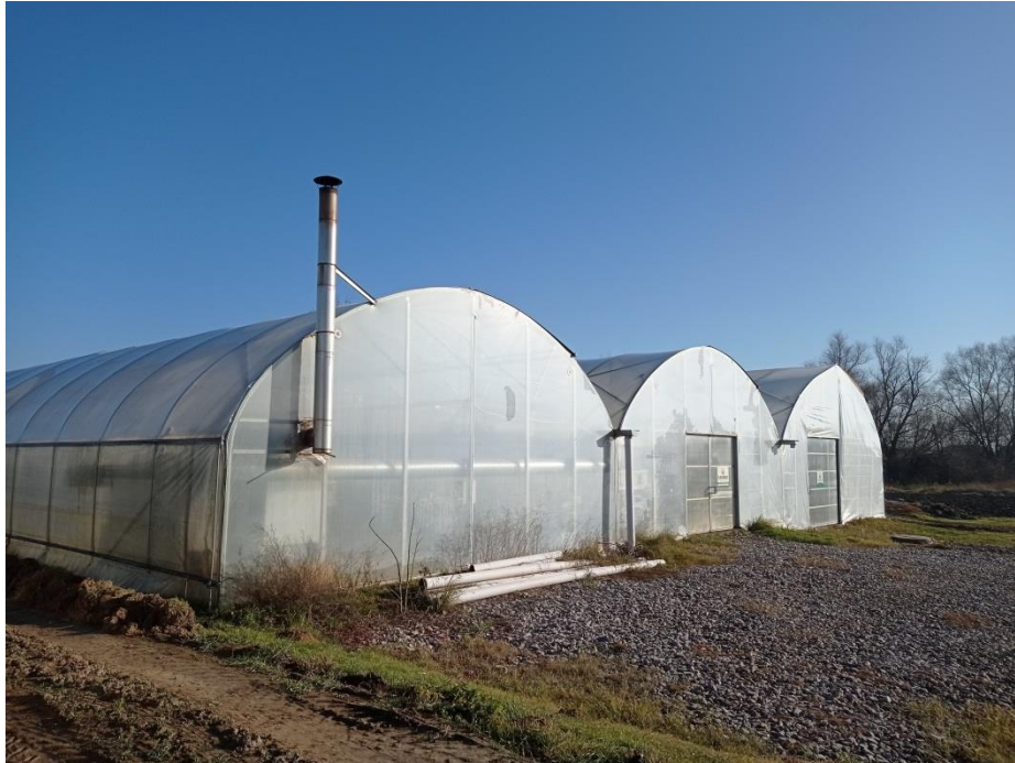
Rysunek 4.12 Tunel wielonawowy produkcji polskiej. Widoczny system ogrzewania nadmuchowego wraz z emitorem oraz rynny odprowadzające deszczówkę. Źródło: opracowanie własne
