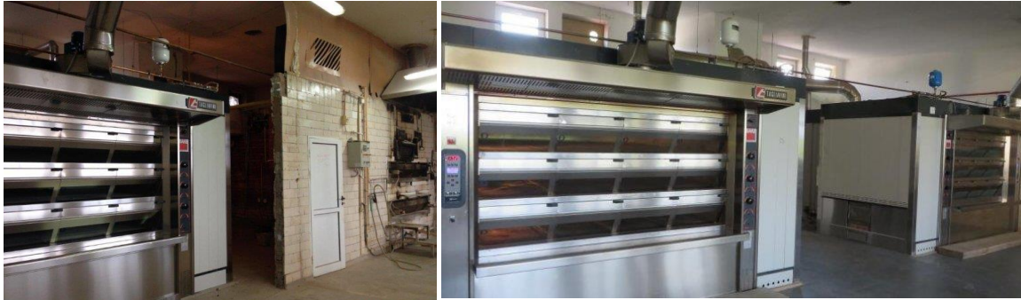
Rysunek 5.14 Widok pieców RRK w trakcie modernizacji. Źródło: www.bakeres.pl
