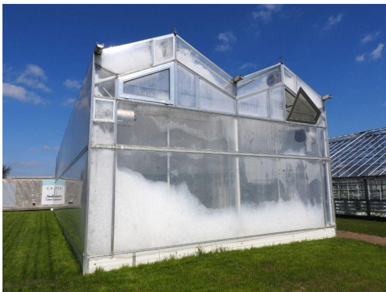
Rysunek 6.21 Szklarnia bąbelkowa – włączanie piany w ściany (fot. Agnieszka Marczyńska, źródło: https://www.wodr.poznan.pl/sir/aktualnosci/item/6201-innowacyjna-aktywna-cieplarnia-na-universytecie-przyrodniczym-w-poznaniu )
