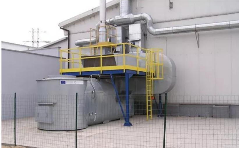
Rysunek 5.8 Dopalacz katalityczny połączony z systemem odzysku ciepła. Źródła: www.bodim.eu
