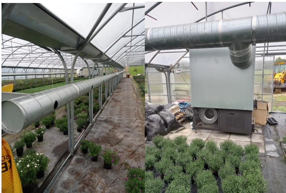
Rysunek 4.5 System nadmuchu ciepłego powietrza w obiekcie szklarniowym wielonawowym. Źródło: opracowanie własne
