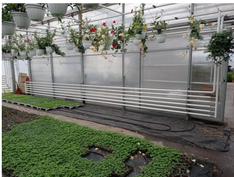
Rysunek 4.3 Wymienniki boczne w obiekcie szklarniowym. Źródło: opracowanie własne
