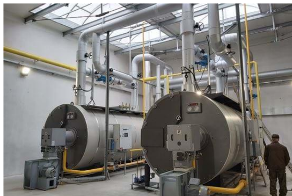
Rysunek 6.17 A) Nowy obiekt GPR Krason w Kisielach (fotografia: https://www.e-warzywnictwo.pl ), B) Kotły kogeneracyjne na gaz ziemny o łącznej mocy 2,7 MW (źródło: https://www.certhon.com )
