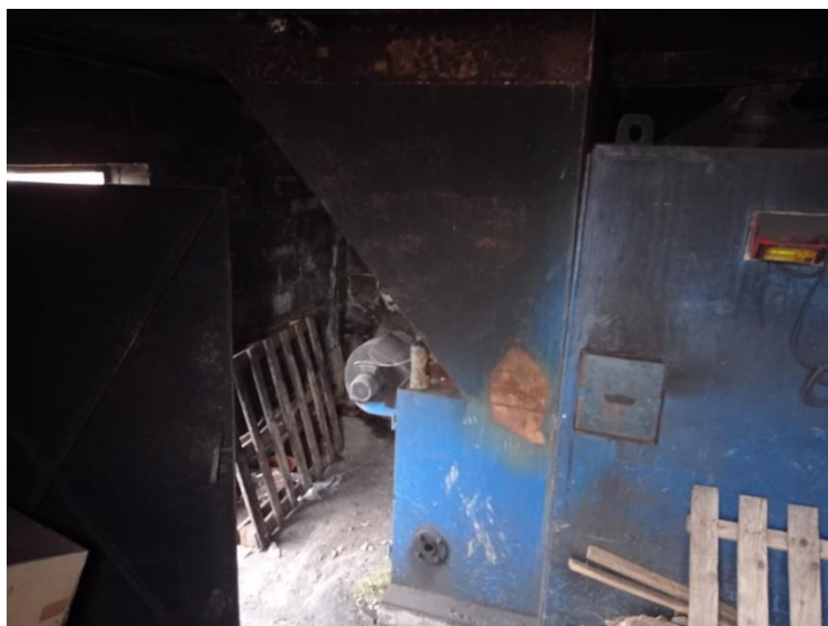
Rysunek 4.7 Widok na piec CO zasilany miatem węglowym o mocy około 500kW. Źródło: opracowanie własne
