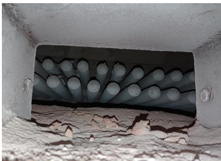
Rysunek 4.32 Końcówki rurek Perkinsa w piecu RRK. Źródło: opracowanie własne
