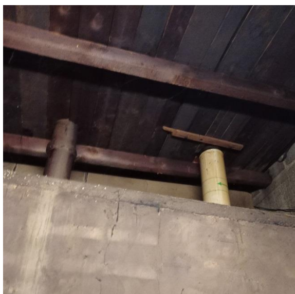
Rysunek 4.50 Odprowadzenie gazów odlotowych do atmosfery odbywa się przy pomocy kominów zabudowanych w górnej części komory wędzarniczej. Wewnątrz komory znajduje się na wlocie do kominu specjalna przesłona umożliwiająca regulację ciągu. Źródło: opracowanie własne
