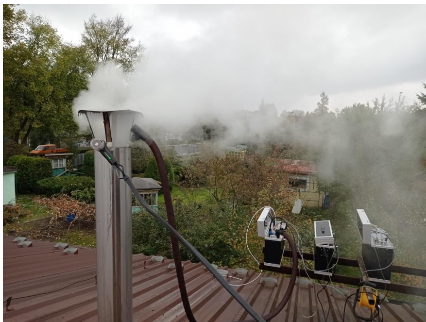
Rysunek 4.62 Widok na urządzenia pomiarowe w trakcie wykonywanych badań. Ze względu na warunki techniczne nie wykonywano otworów w przewodzie kominowym. Widoczna duża gęstość dymu. Źródło: opracowanie własne
