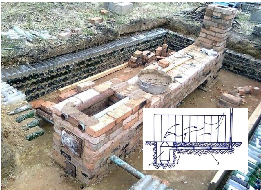
Rysunek 6.23 Oryginalna konstrukcja pieca szamotowego ogrzewającego glebę (źródło: https://buildex.techinfus.com/es/obogrevateli/dymohod-v-teplice.html )
