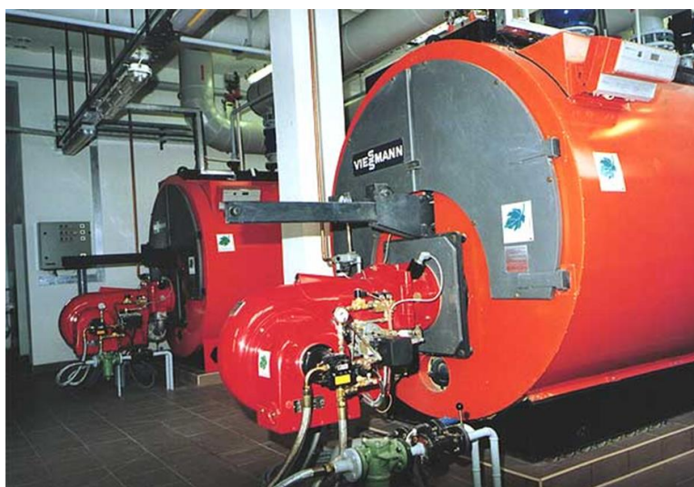
Rysunek 3.9 Przykładowy kocioł na lekki olej opałowy znanej firmy niemieckiej (źródło: https://www.technika-szklarniowa.pl )
