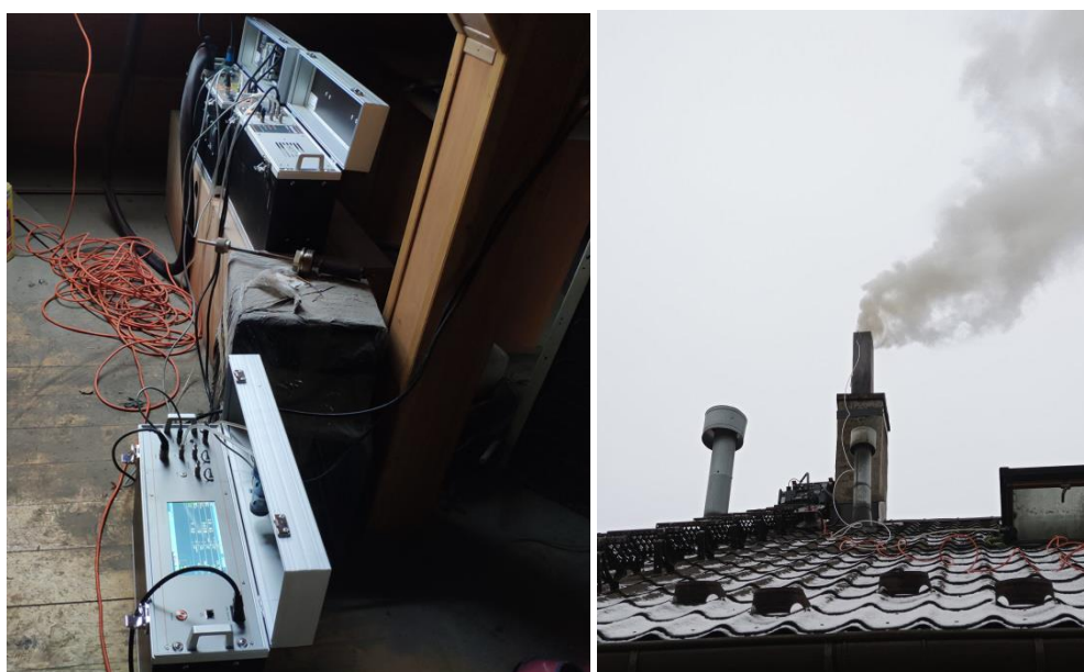
Rysunek 4.44 Aparatura pomiarowa oraz emitor odprowadzający gazy odlotowe ze źródła. Źródło: opracowanie własne
