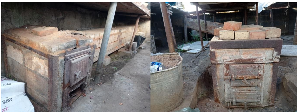
Rysunek 4.14 Akumulacyjno-radiacyjne urządzenia grzewcze szklarni starego typu. Tego typu urządzeń jest nadal całkiem sporo, szczególnie u gospodarzy produkujących na małą skalę. Źródło: opracowanie własne
