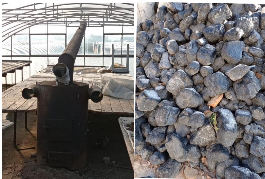
Rysunek 4.16 Po lewej stronie widok na urządzenie ogrzewcze nadmuchowe własnej produkcji. Długi przewód odprowadzający gazy odlotowe dodatkowo odzyskuje ciepło. Po prawej stronie zgromadzone paliwo na okres zimowy. Źródło: opracowanie własne
