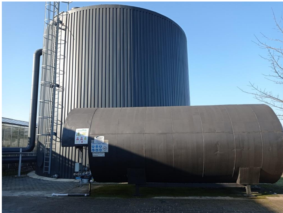
Rysunek 4.22 Zbiornik na CO 2 skroplony (na pierwszym planie) użytkowany w jednym z obiektów szklarniowych. Źródło: opracowanie własne
