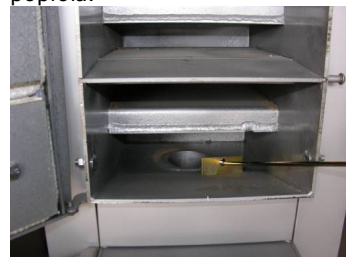
Fot.6. Pozostałości pyłu zgarnąć grąką do otworu paleniska.
