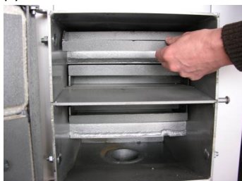
Fot.7. Po wyczyszczeniu półek założyć turbolizery. /12 i 18 kW/
