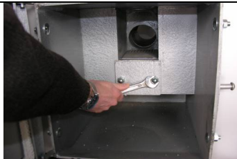
Fot.2. Odkręcić nakrętki pokrywy wyczystki komory powietrznej.
