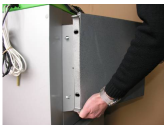
Fot.8. Odwrócić drzwiczki i zamontować do włazu po drugiej stronie.
