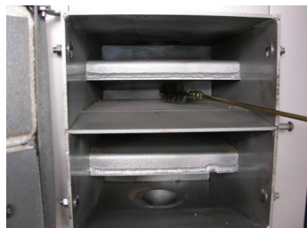
Fot.5. Powierzchnie wymiennika czyścić szczotką.
