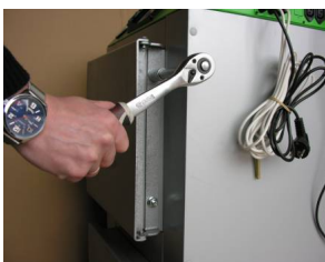
Fot.7. Zdemontować drzwiczki z włazu.
