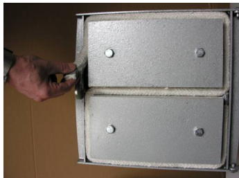
Fot.8. Wymiana uszczelki ceramicznej drzwiczek.
