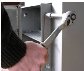
Fot.10. Zamontować rygiel po drugiej stronie.
