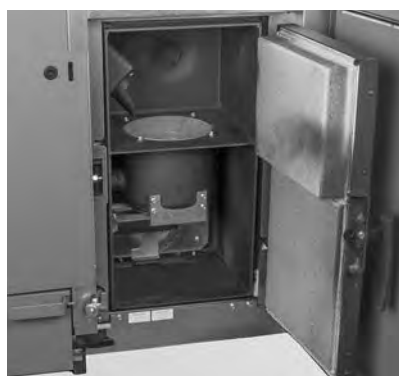
rys.25 Otwórz drzwiczki zewnętrzne oraz drzwiczki komory spalania
