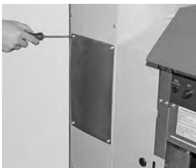
rys. 65 Odkręć śruby i usuń pokrywę rewizyjną
