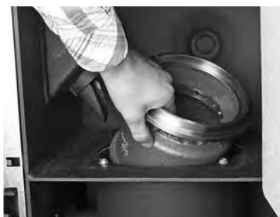
rys.40 Wyjmij dolną część konusa
