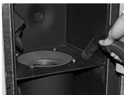
rys.38 Usunąć resztki popiołu i zanieczyszczeń
