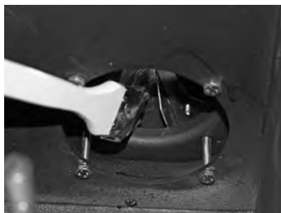
rys. 55 Wyczyścić i odkurzyć śmigło wentylatora
