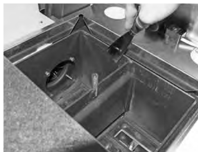
rys. 56 Wyczyścić wymiennik ciepła
