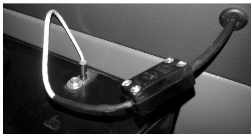
Rysunek 4 Czujnik temperatury spalin zamontowany w czopuchu
