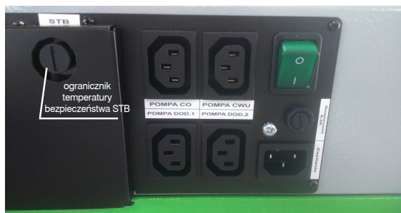
Rysunek 15 Lokalizacja ogranicznika temperatury bezpieczeństwa STB oraz czujnika temperatury
