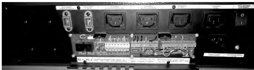
Rysunek 2 Listwa przyłączeniowa do zasilania urządzeń regulacyjnych (Przykładowy wygląd listwy zasilającej w zależności od modelu sterownika zamontowanego na kotle)
