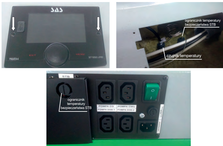
Rysunek 10 Lokalizacja ogranicznika temperatury bezpieczeństwa STB oraz czujnika temperatury
