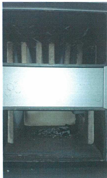
Fot. nr 2. Komora spalania
