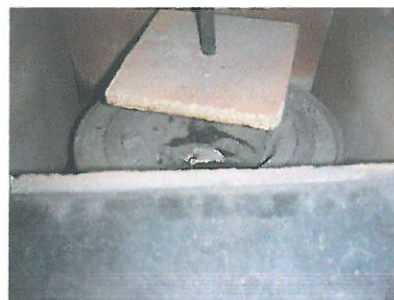
Ceramiczny deflektor i obrotowy palnik retortowy w komorze spalania
