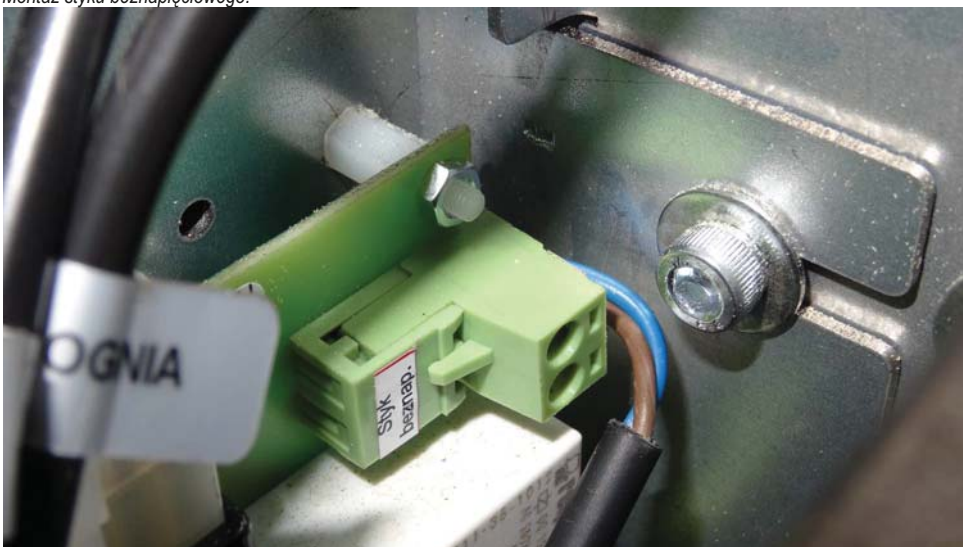
Montaż styku beznapięciowego.
