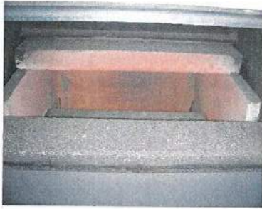
Płyty ceramiczne w górnej części komory spalania
