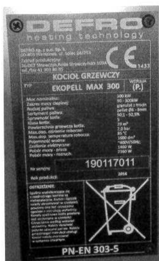
Rys. 2. Tabliczka znamionowa kotła typu Ekopell Max 300.
