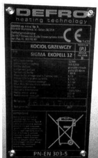
Rys. 2. Tabliczka znamionowa kotła typu Sigma Ekopell 12.
