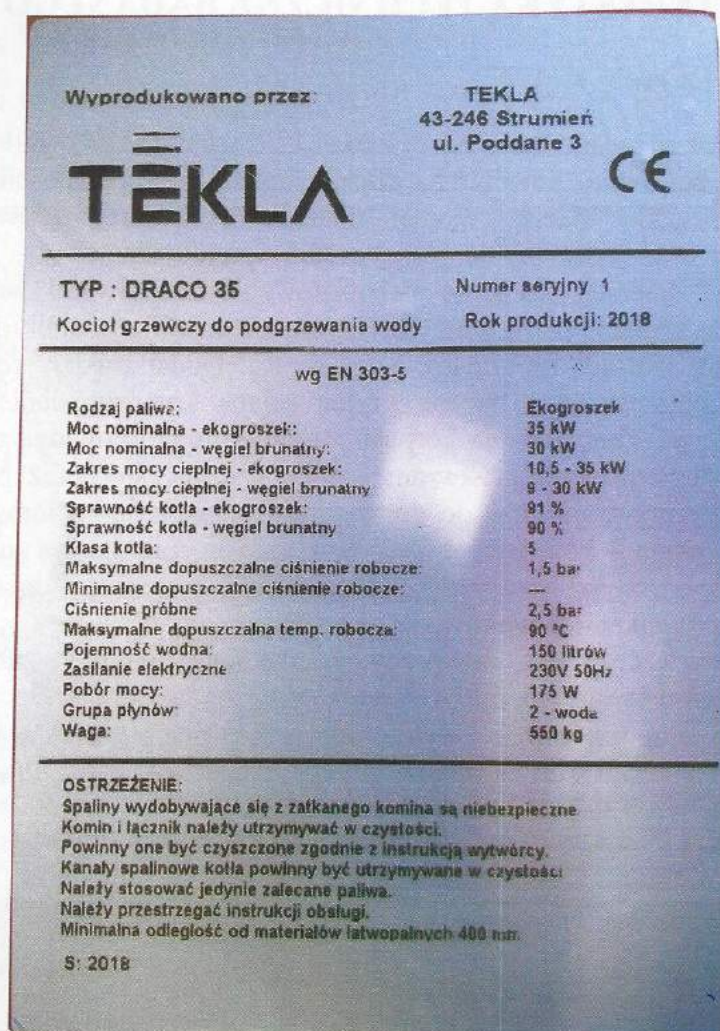
Rysunek 2. Tabliczka znamionowa kotła Draco 35
