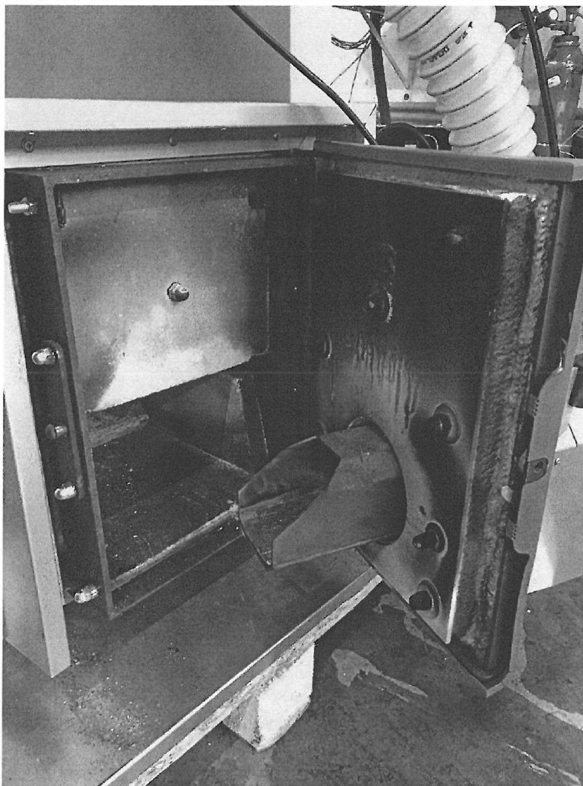
Rysunek 3 Drzwiczki palnika oraz popielnika
