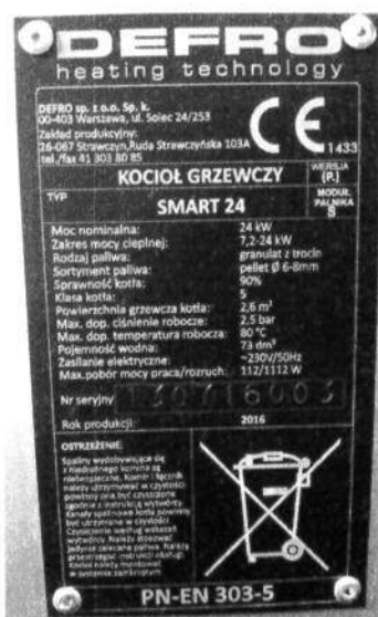
Rys. 2. Tabliczka znamionowa kotła typu Smart Ekopell 24.
