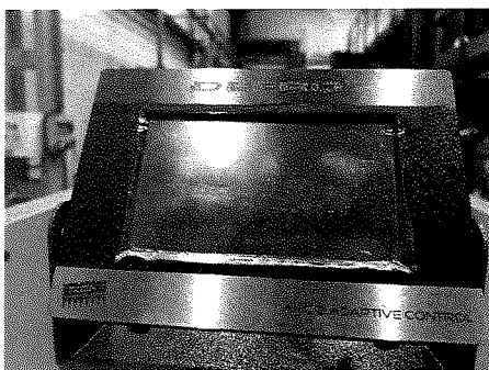
Producent: TECH STEROWNIKI, Spółka z ograniczoną odpowiedzialnością Sp. k., ul. Biała Droga 31, 34-122 Wieprz Typ: APC3 ADAPTIVE CONTROL, zasilanie 230 V/50Hz; maksymalny pobór mocy 10 W; wkładka bezpiecznikowa 6,3 A.; Steruje pompą obiegu wody, pompą ciepłej wody użytkowej (C.W.U.), zaworem mieszającym, pracą zapalarki, wentylatorem palnika, wentylatorem wyciągowym, podajnikiem głównym (spiralą) oraz podajnikiem dodatkowym paliwa (podajnik spiralny w palniku), dodatkowo steruje pracą siłownika układu czyszczenia palnika.
