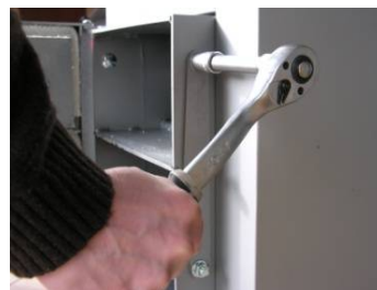
Fot.9. Zamontować rygiel po drugiej stronie.
