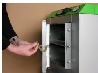
Fot.10. Po odwróceniu zamontować uchwyt zaciskowy.
