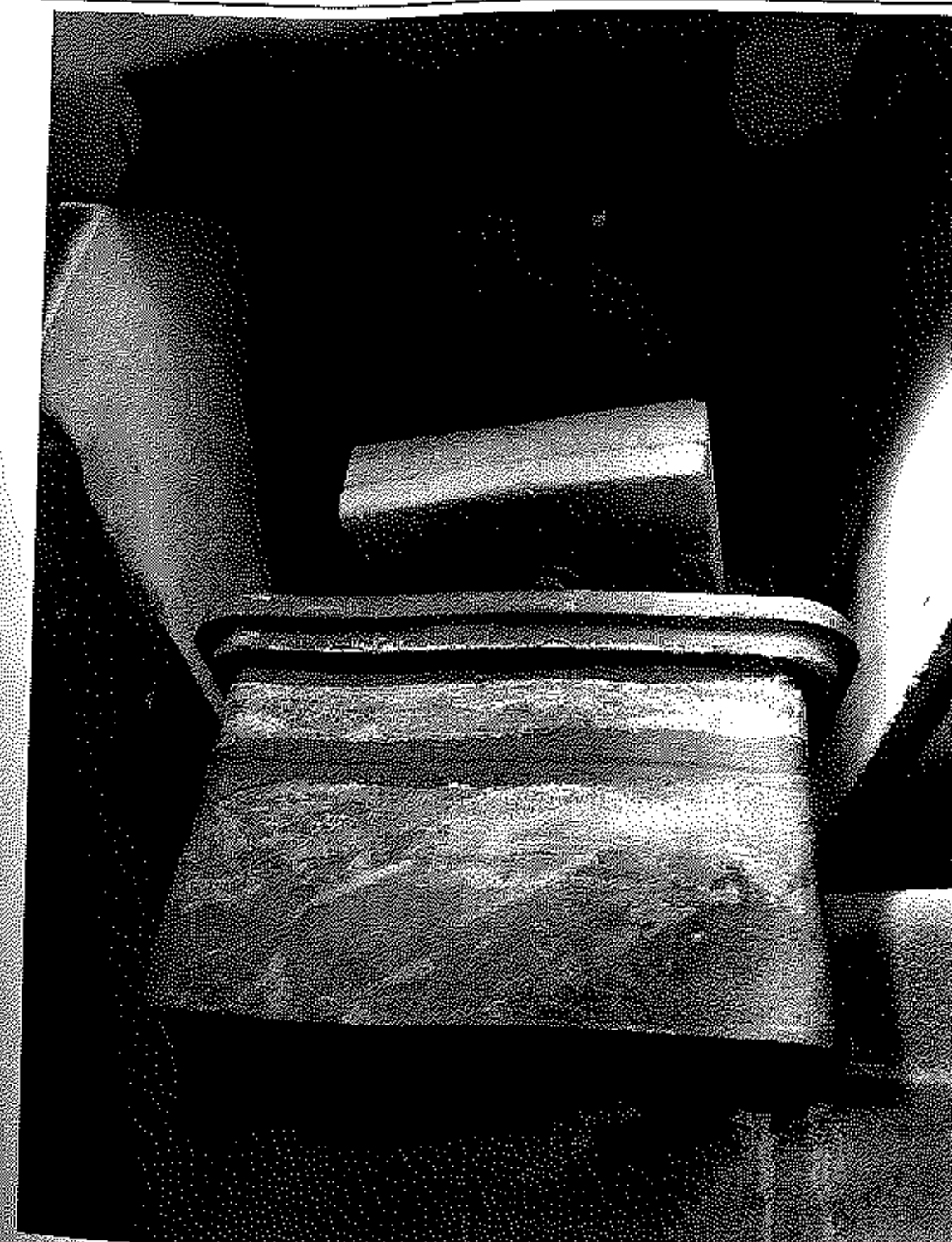
Rysunek 9 Elementy ceramiczne kotła
