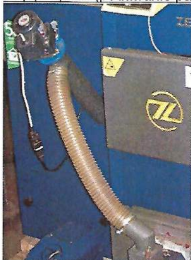
Napęd spirali (podawanie paliwa do modułu palnika)
