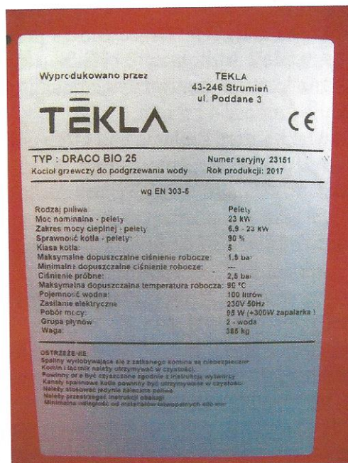
Rys. 2. Tabliczka znamionowa kotła typu Draco Bio 25.
