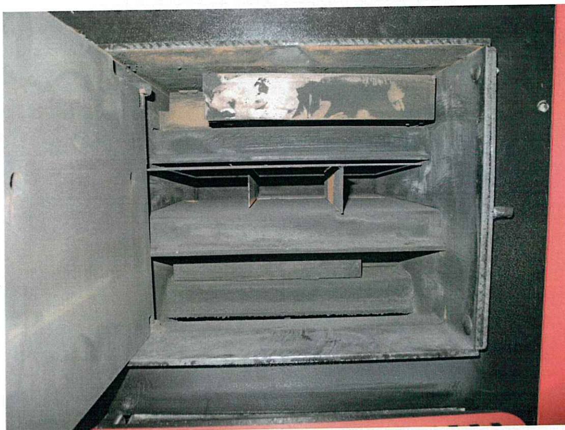
Rysunek 4.3. Komora konwekcyjna wraz z zawiórowywaczami
