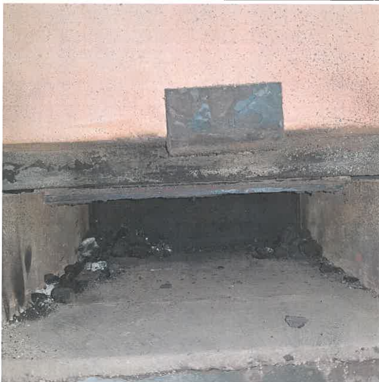
Rysunek 10 Widok wnętrza palnika szufladowego
