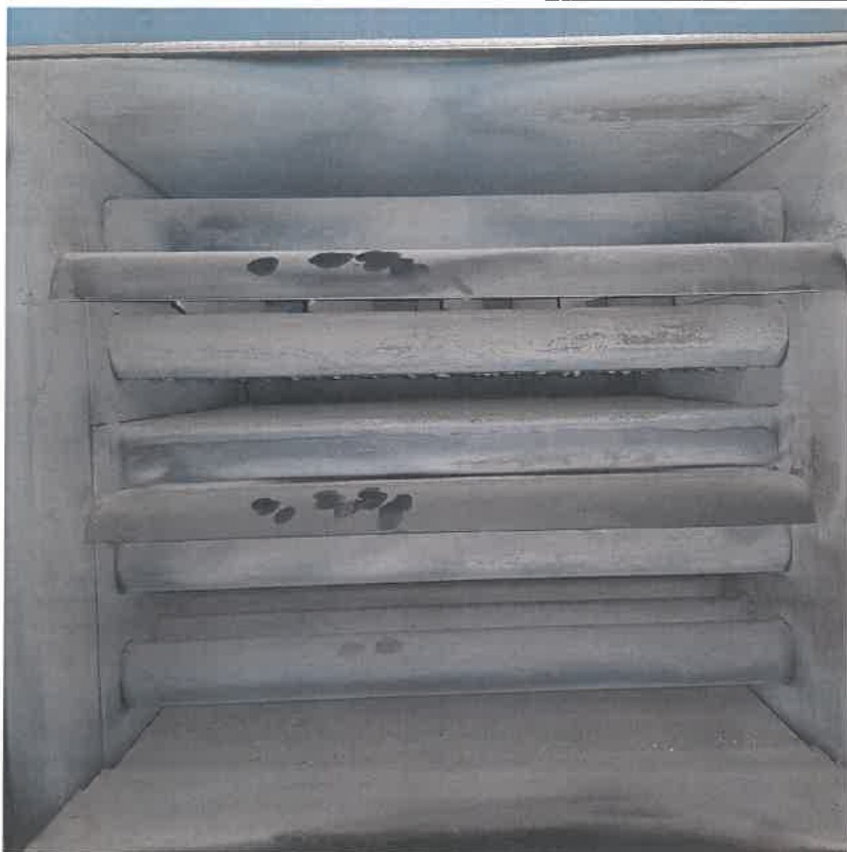
Rysunek 5 Górna część wymiennika oraz zawirowywacze (2 sztuki)
