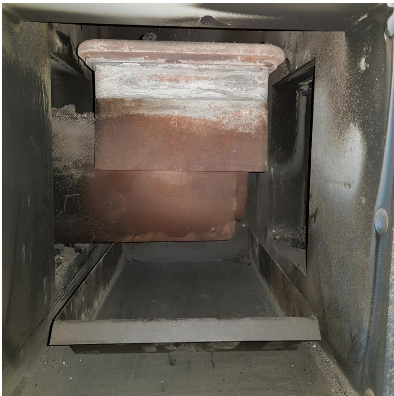
Rysunek 13 Komora spalania oraz palnik retortowy 15–25 kW produkcji P.H.U.P. Ekoenergia S.C.
