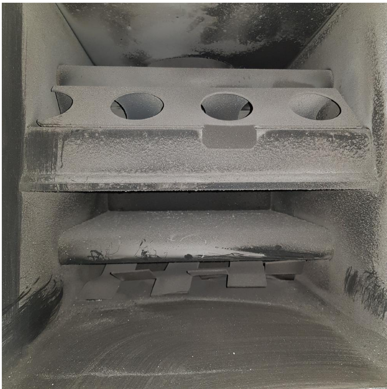
Rysunek 9 Wymiennik oraz zawirowywacze
