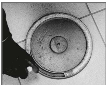
Fot. Wymiana sznura uszczelniającego.
