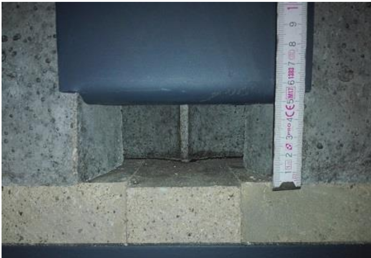
Rys. nr 9. Ustawienie przesłony przy paleniu drewnem z mocą nominalną.
