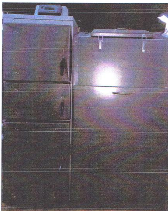
Rys. 1. Kocioł grzewczy typu Technix 12.
