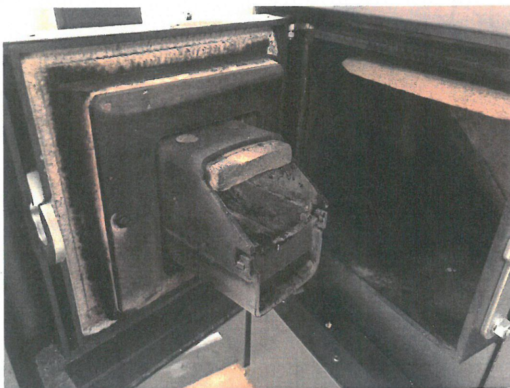
Rysunek 8 Palnik pelletowy z ruchomym rusztem PS10 produkcji STALMARK Sp. z o.o. Sp. K.
