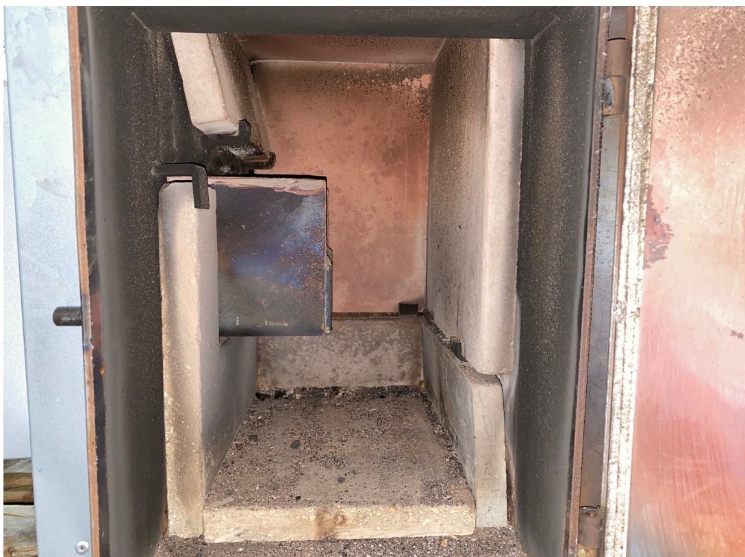
Rysunek 9 Elementy ceramiczne komory spalania oraz palnik szufladowy
