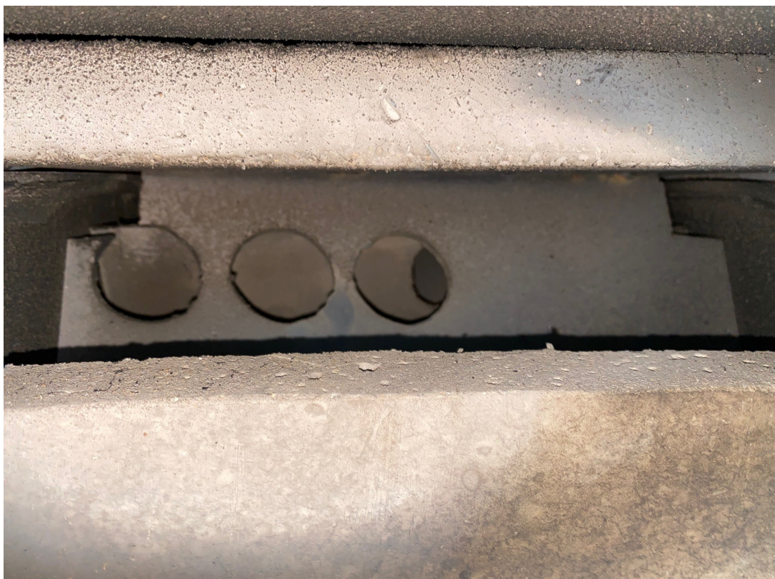
Rysunek 8 Rodzaj zamontowanego zawiorowywacza w dolnej części wymiennika
