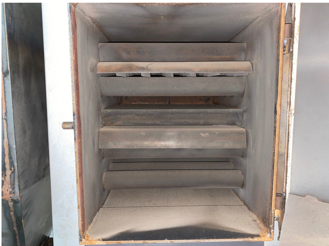
Rysunek 5 Górna część wymiennika oraz zawirowywacze (2 sztuki)
