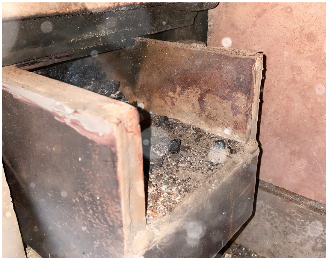
Rysunek 10 Widok wnętrza palnika szufladowego
