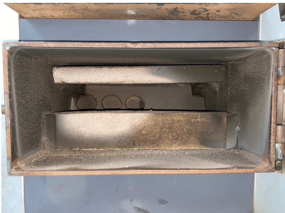
Rysunek 6 Dolna część wymiennika, zawirowywacz oraz elementy ceramiczne
