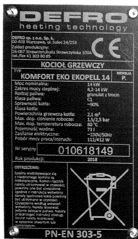
Rysunek 2. Tabliczka znamionowa kotła KOMFORT EKO EKOPELL 14
