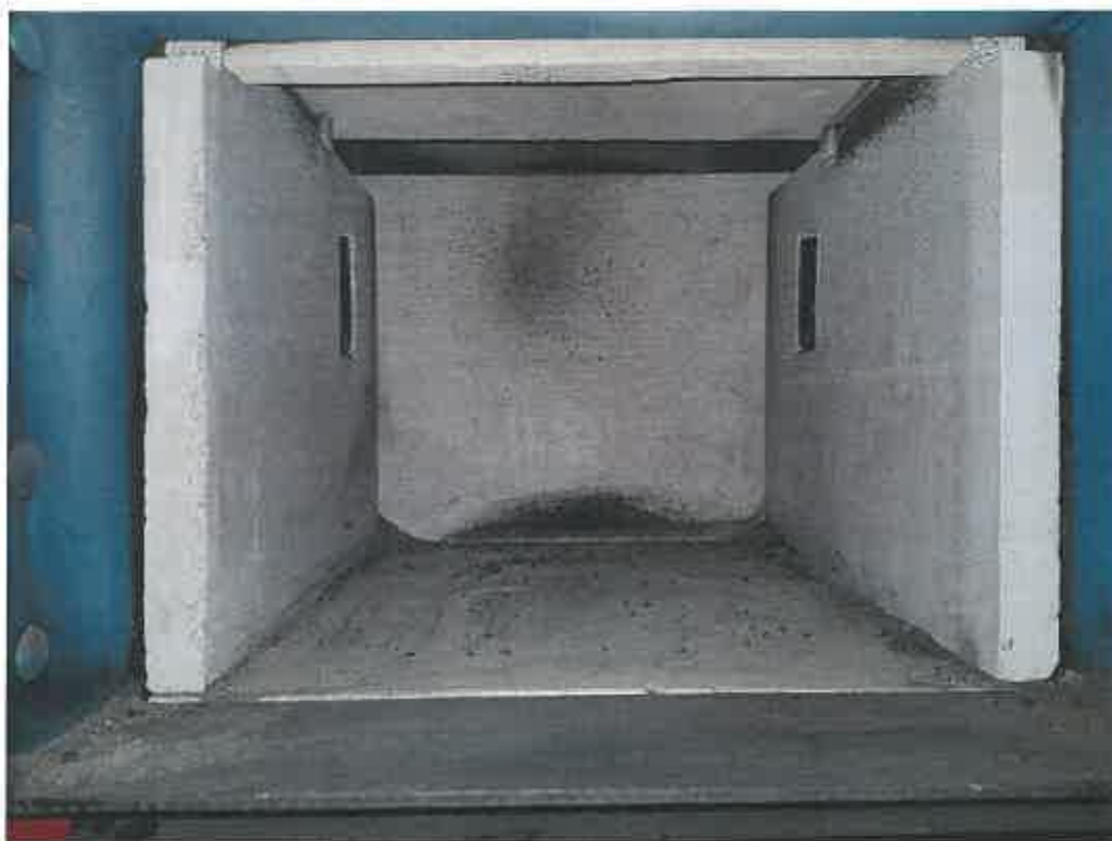
Rysunek 6 Elementy ceramiczne komory spalania
