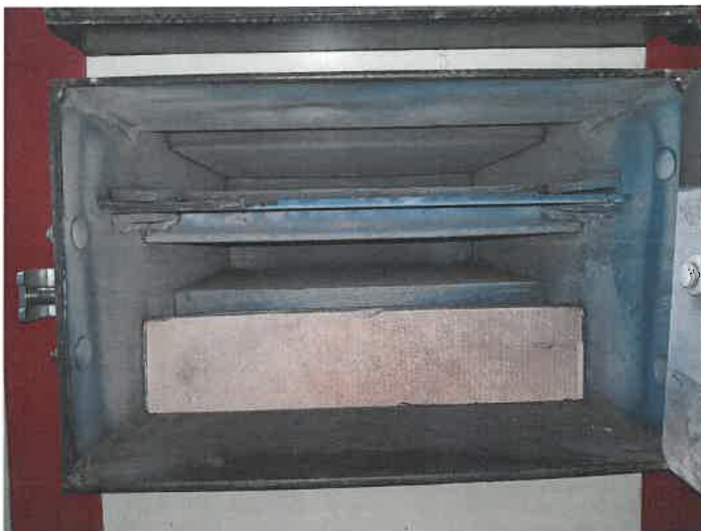
Rysunek 7 Dolna część wymiennika
