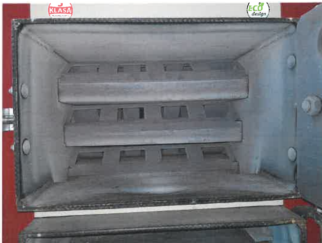
Rysunek 8 Górna część wymiennika oraz zawirowywacze
