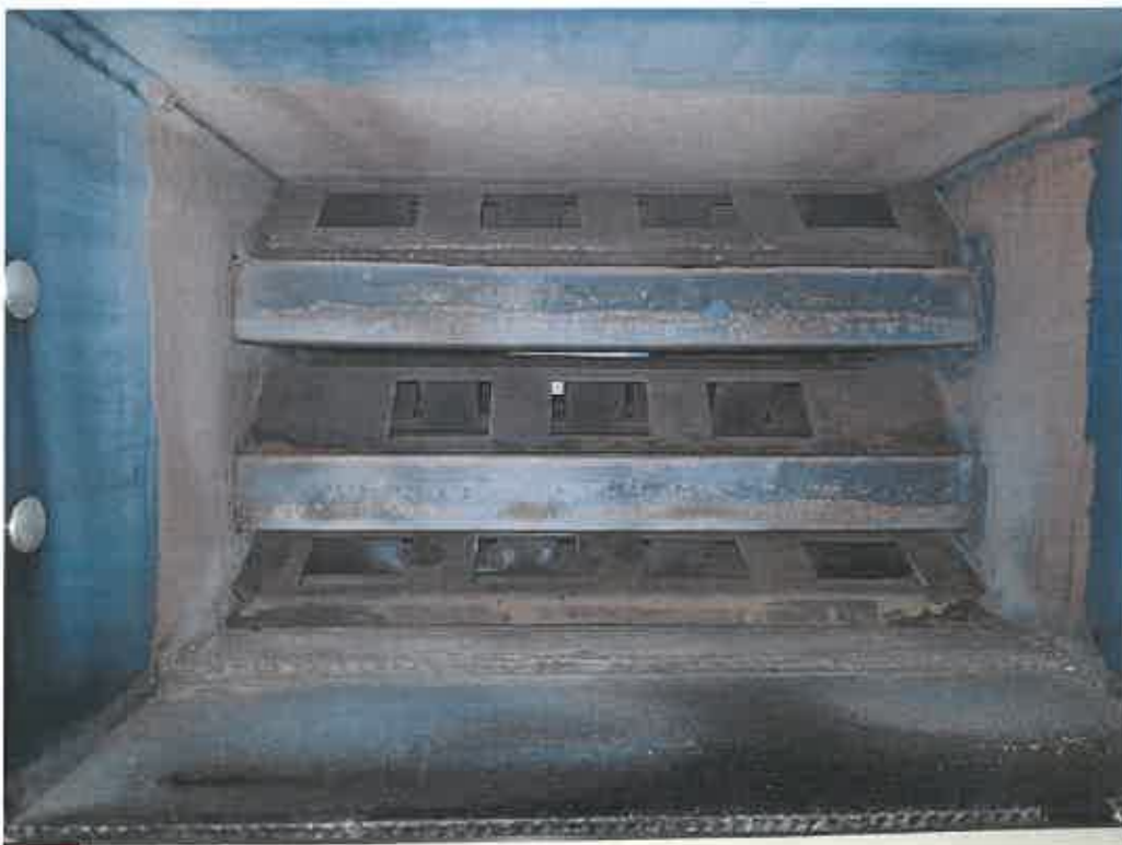
Rysunek 8 Górna część wymiennika oraz zaworowycze
