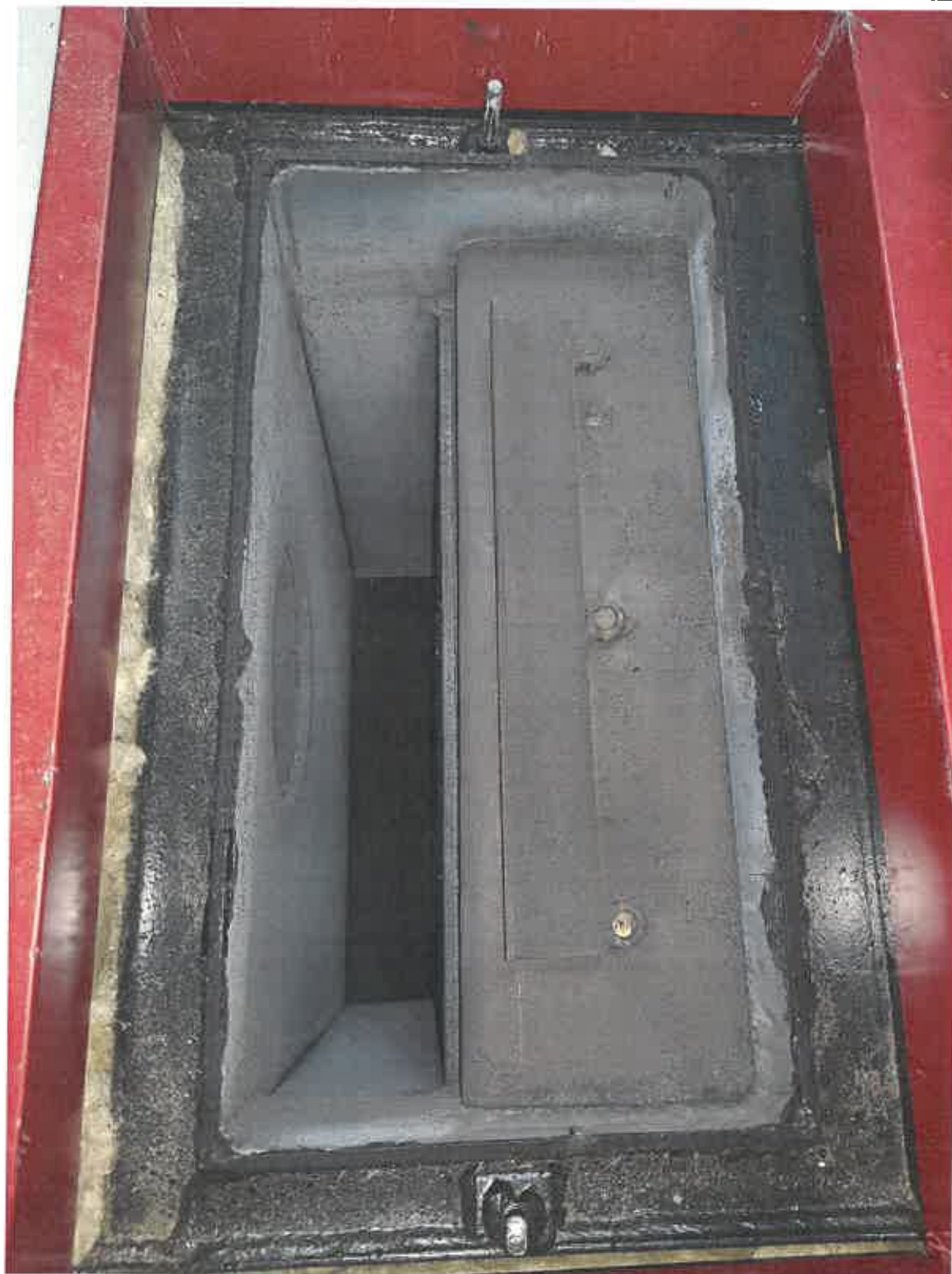
Rysunek 8 Wymiennik pionowy z zamontowanym układem zawirowywaczy
