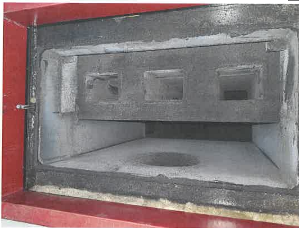
Rysunek 9 Wymiennik pionowy po zdemontowaniu zawirowywaczy
