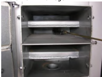
Fot.5. Powierzchnie wymiennika czyścić szczotką lub odkurzaczem.
