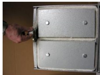
Fot.9. Wymiana uszczelki ceramicznej drzwiczek
