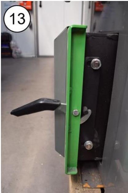
Zdj.13. Drzwi popielnika (sposób zamknięcia- niedomknięte)
