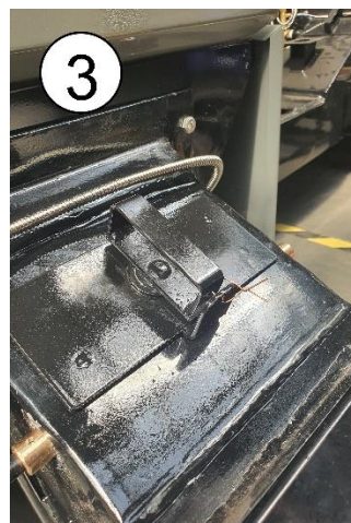
Zdj. 3. Kłapa rewizyjna paleniska (DOBRZE)
