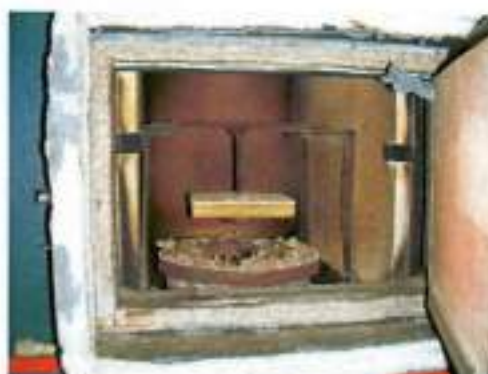
Palnik firmy Pancerpol Typ PPS 15 kW
