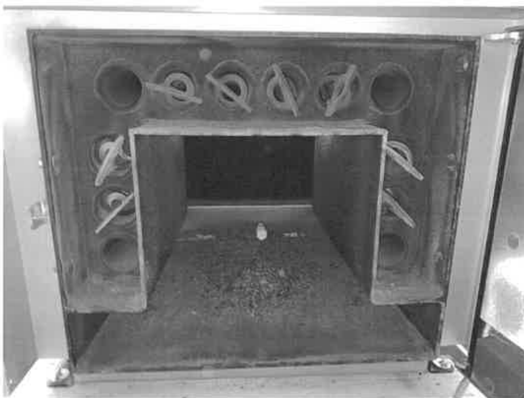
Rysunek 6 Komora spalania, komora popielnikowa oraz rury płomieniowe z zainstalowanymi zaworami
