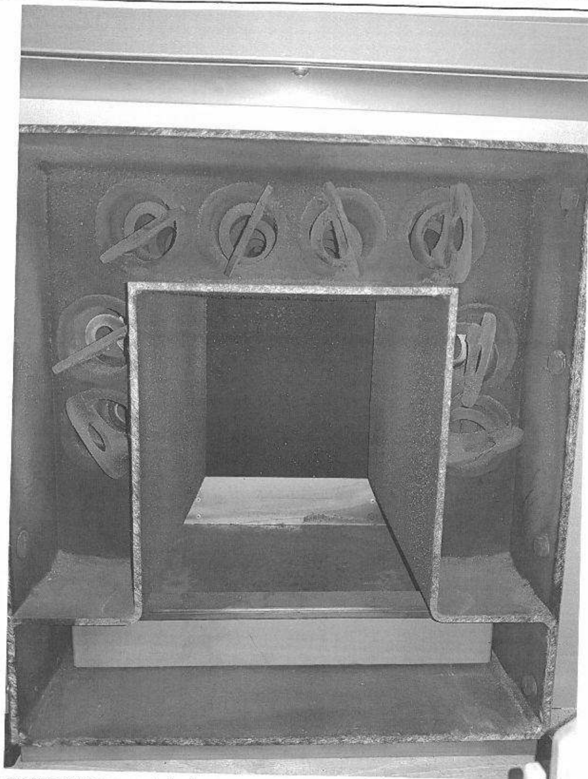
Rysunek 7 Komora spalania, komora popielnikowa oraz rury płomieniowe z zainstalowanymi zawirowywaczami
